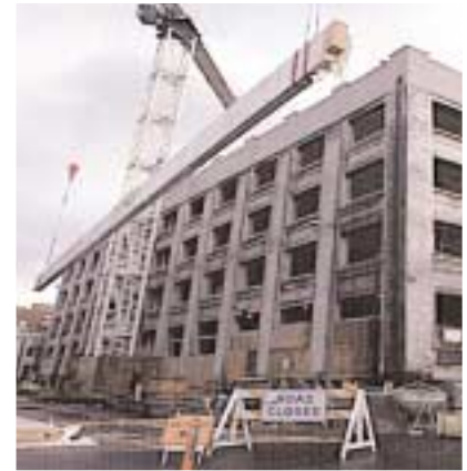
塔式起重机和吊杆起重机共同将重达6.4公吨的梁吊装到楼顶。
