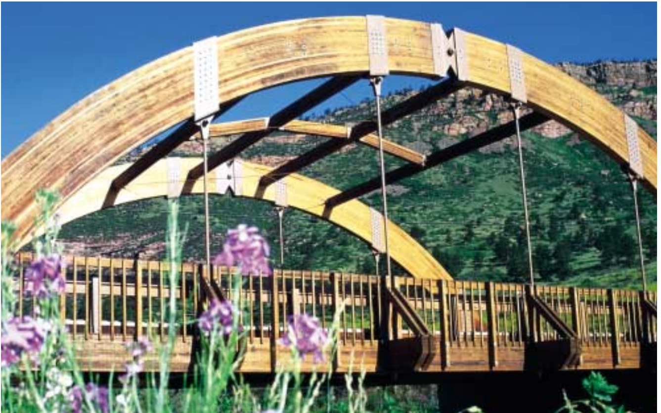
科罗拉多州双车道公路桥，采用胶合木径向拱形。
