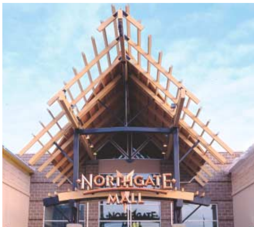
暴露的APA EWS胶合木构成Northgate商业中心的入口门框，格外醒目。
