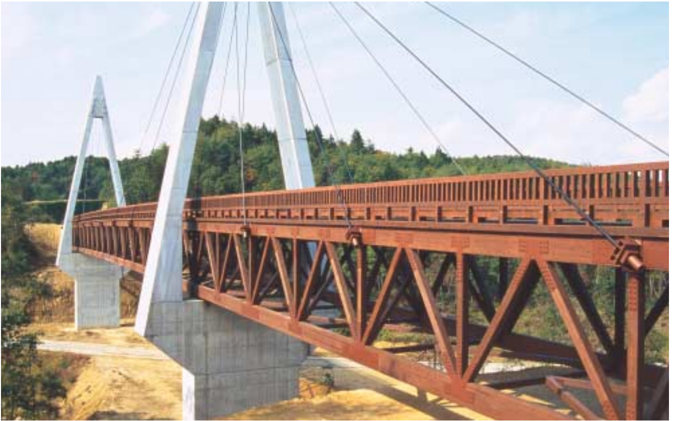
日本广岛采用胶合木为桁架的公路桥。
