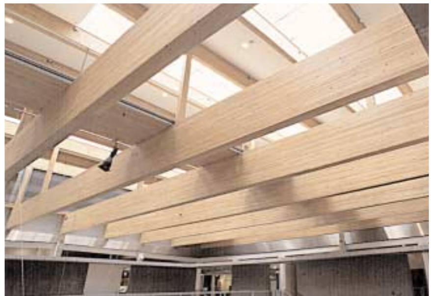
仰视巨大的30厘米×135厘米×31米胶合木梁。在照片中间靠左的位置可以见到一座天桥横跨木梁。
