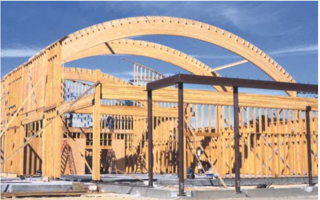
加利福尼亚州 Salinas市的斯坦贝克中心，曲梁决定了这座建筑物的设计。
