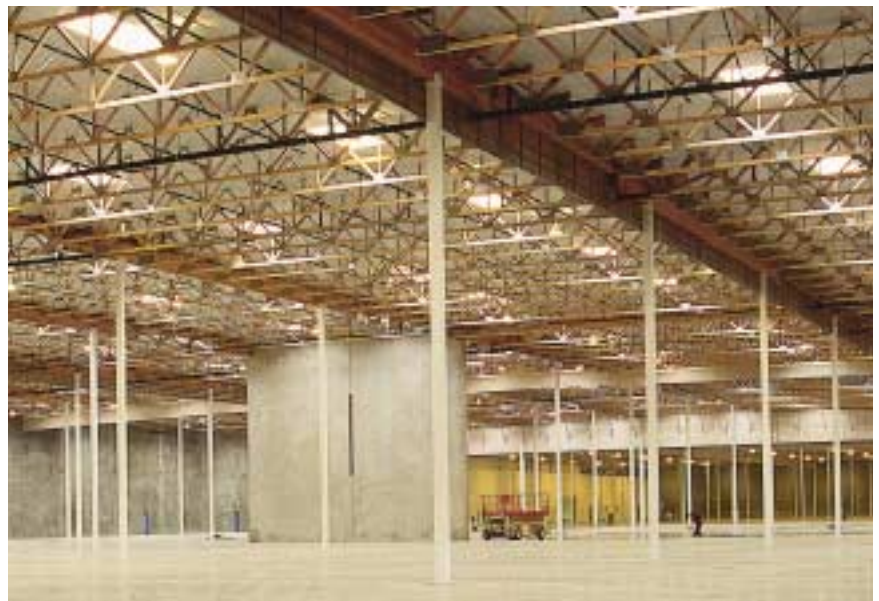
在已完工的屋顶系统中可以见到胶合木桁架。
