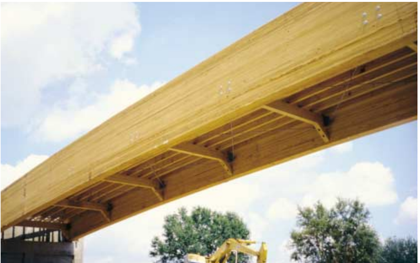
佛罗里达州 Orlando市高尔夫球场，正在修建供行人与轻型车辆行走的胶合木桥梁。
