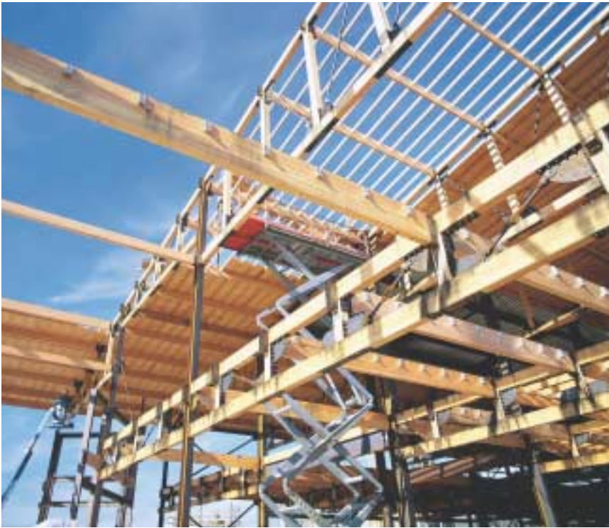
施工中的胶合木檩条和桁架。
