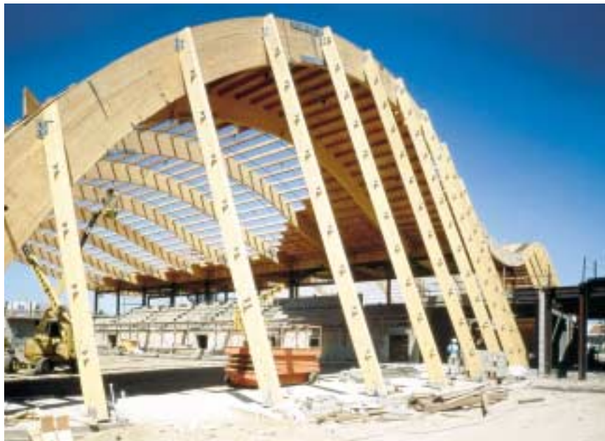
胶合木拱顶弯成一个23米半径，形成溜冰中心的屋顶系统。
