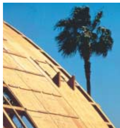
用手将胶合板在弧形胶合木梁上弄弯曲非常困难。
