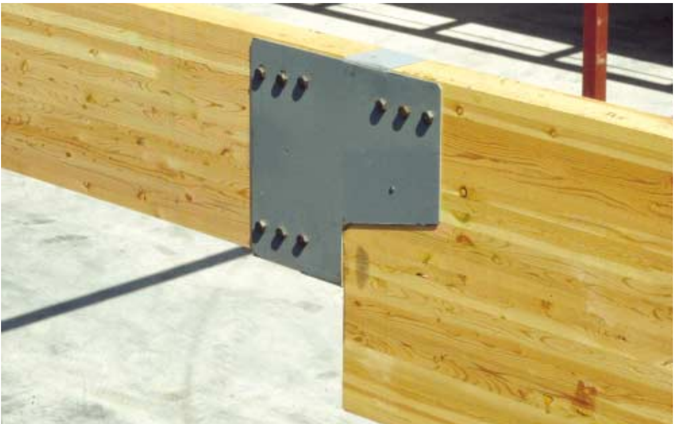
悬臂铰链连接装置，用于板块式屋顶。
