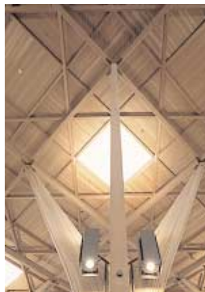
7.9米高的胶合木树和胶合木檩条支撑着胶合木盖板。
